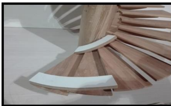
شکل ۲- نحوه الگوبرداری دسته نرده
