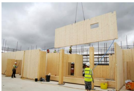
شکل ۱- نمایی از نحوه چیدمان لایه‌های CLT و محصول واقعی و کاربرد آن در ساختمان
