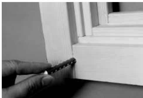
شکل ۲- میله‌های حفاظتی پرشده با بورات‌ها در حال قرار گرفتن در اتصال L شکل در پنجره‌های چوبی [۴]
